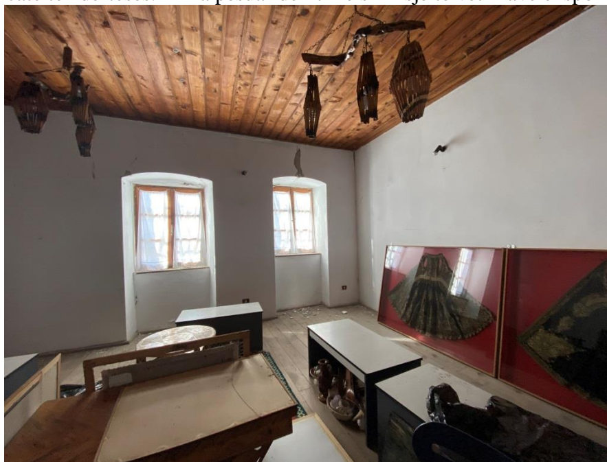
Foto e realizuar në objekt pas tërmetit
