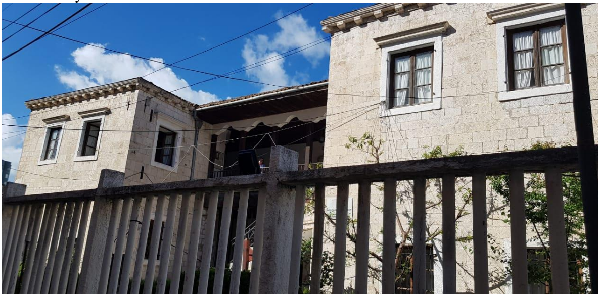
Foto e realizuar në objekt para tërmetit
