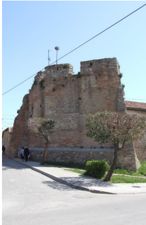
Foto e realizuar në objekt para tërmetit
