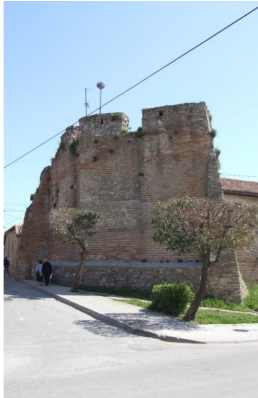
Foto e realizuar në objekt para tërmetit
