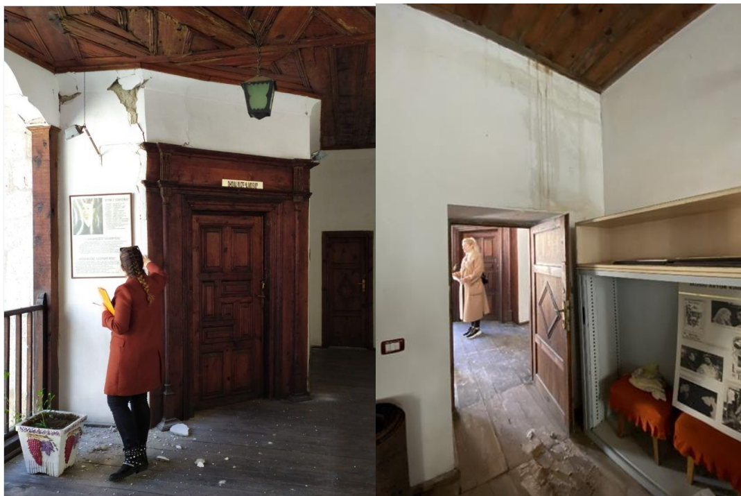
Foto e realizuar në objekt pas tërmetit
