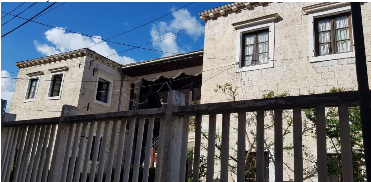
Foto e realizuar në objekt para tërmetit
